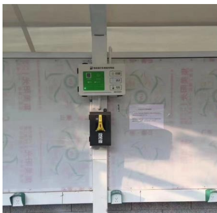
室内充电桩安装案例
