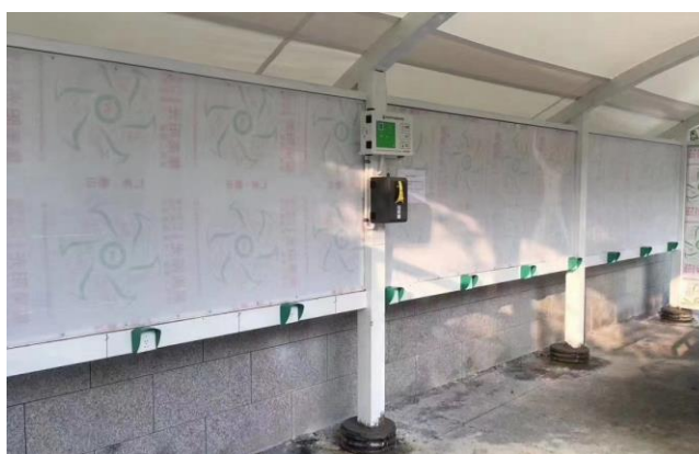
室外充电桩安装案例
