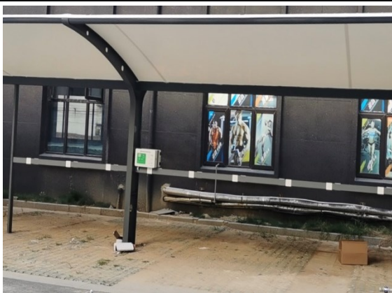
室内充电桩安装案例
