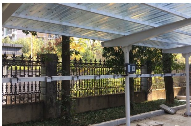
室外充电桩安装案例
