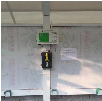
室内充电桩安装案例
