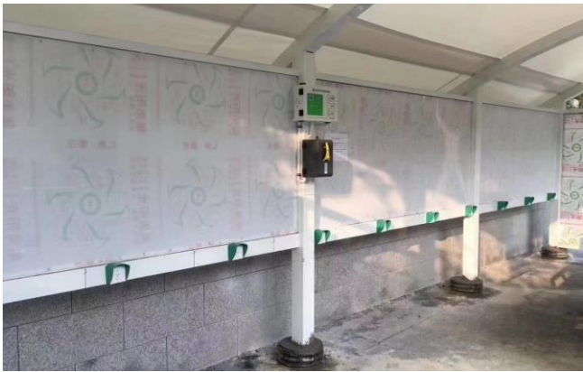
室外充电桩安装案例
