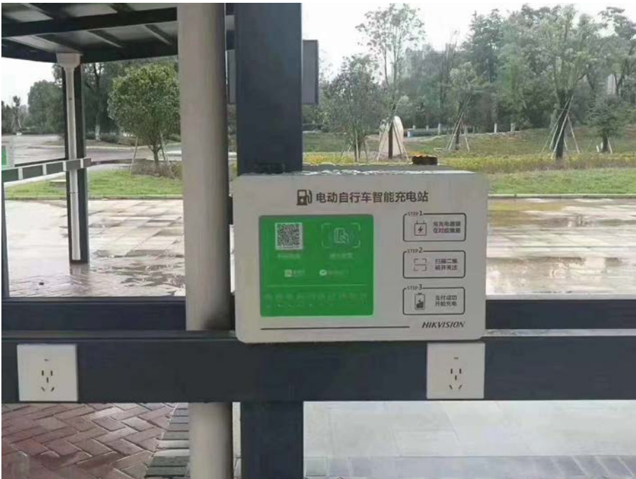
江西某小区充电桩安装案例
