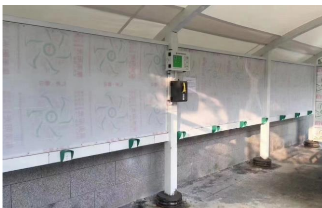
室外充电桩安装案例
