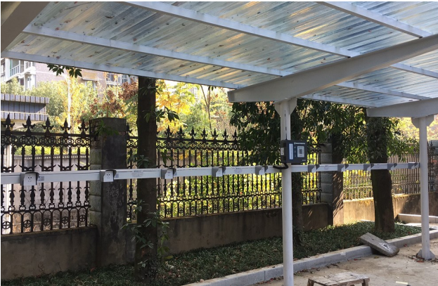
室外充电桩安装案例
