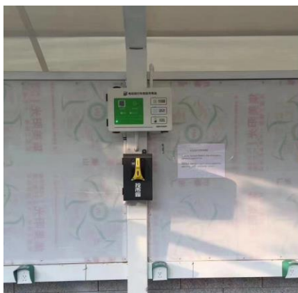
室内充电桩安装案例
