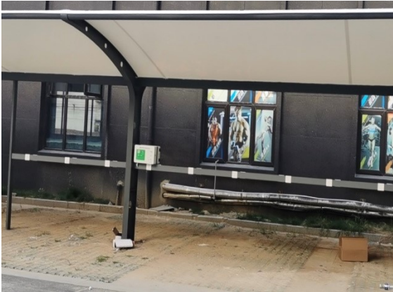
室内充电桩安装案例
